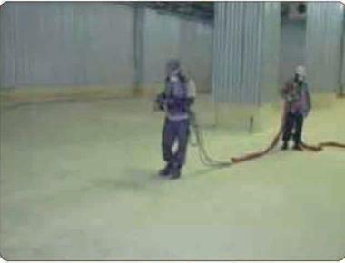
냉동창고 벽면·바닥 스프레이 시공
