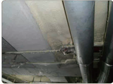
일반 건축물 천정부 스프레이 시공
